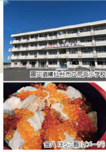
震災遺構 仙台市立荒浜小学校
